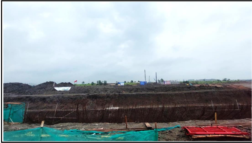
TAMPAK LOKASI RENCANA PEMBANGUNAN RAW MATERIAL STORAGE
