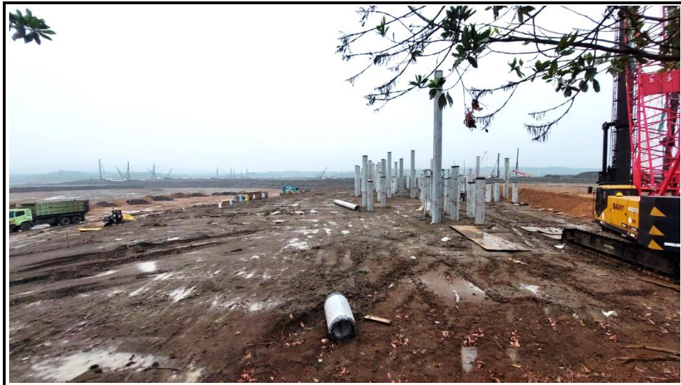
TAMPAK LOKASI RENCANA PEMBANGUNAN RAW MATERIAL STORAGE
