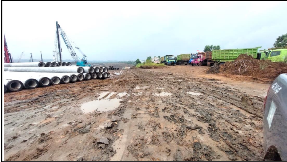
TAMPAK SITUASI JALAN PADA AREA PEMBANGUNAN
