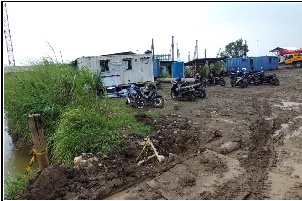
TAMPAK DEPAN SITE OFFICE PADA AREA PEMBANGUNAN
