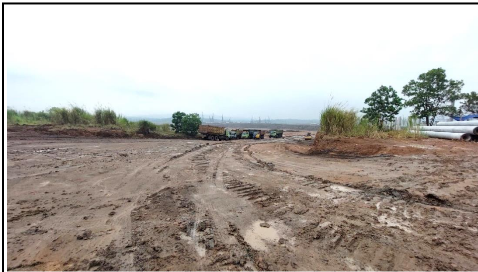
TAMPAK SITUASI JALAN PADA AREA PEMBANGUNAN
