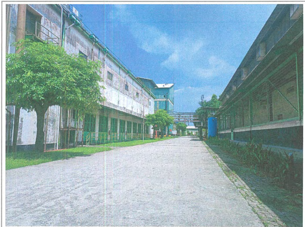
TAMPAK LOKASI SHGB NO. 91
