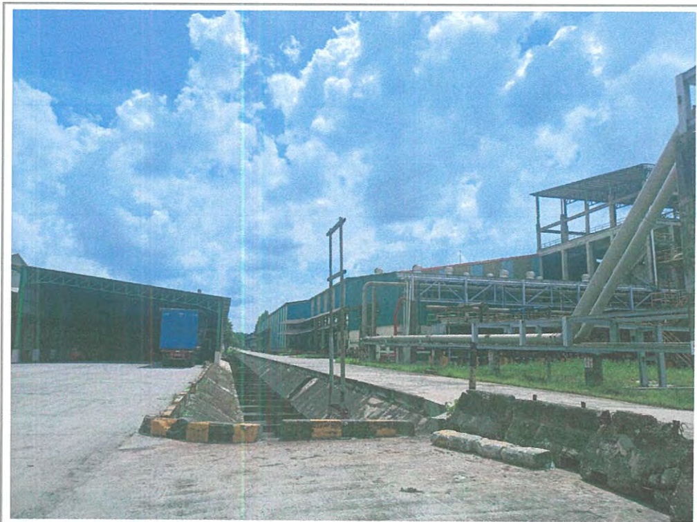
TAMPAK LOKASI SHGB NO. 473
