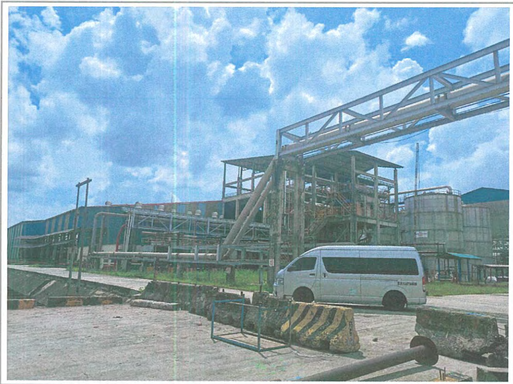
TAMPAK LOKASI SHGB NO. 473
