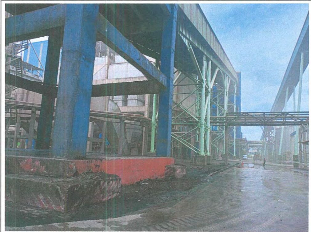
TAMPAK LOKASI SHGB NO. 89
