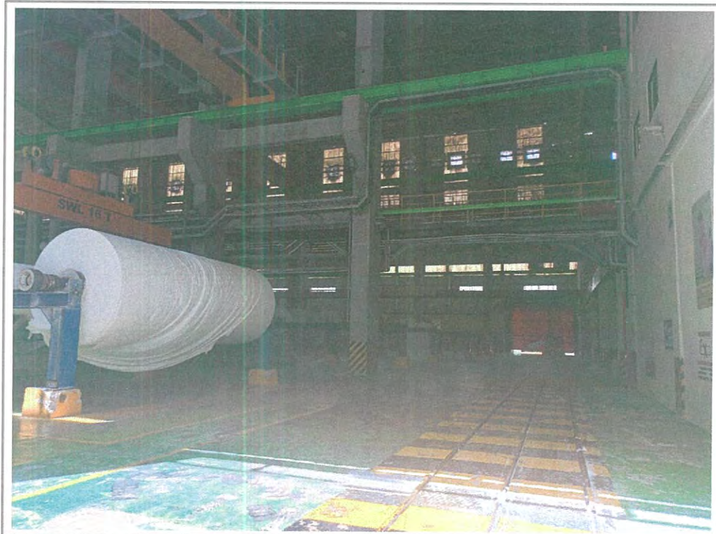
TAMPAK LOKASI SHGB NO. 473 (DALAM PABRIK)
