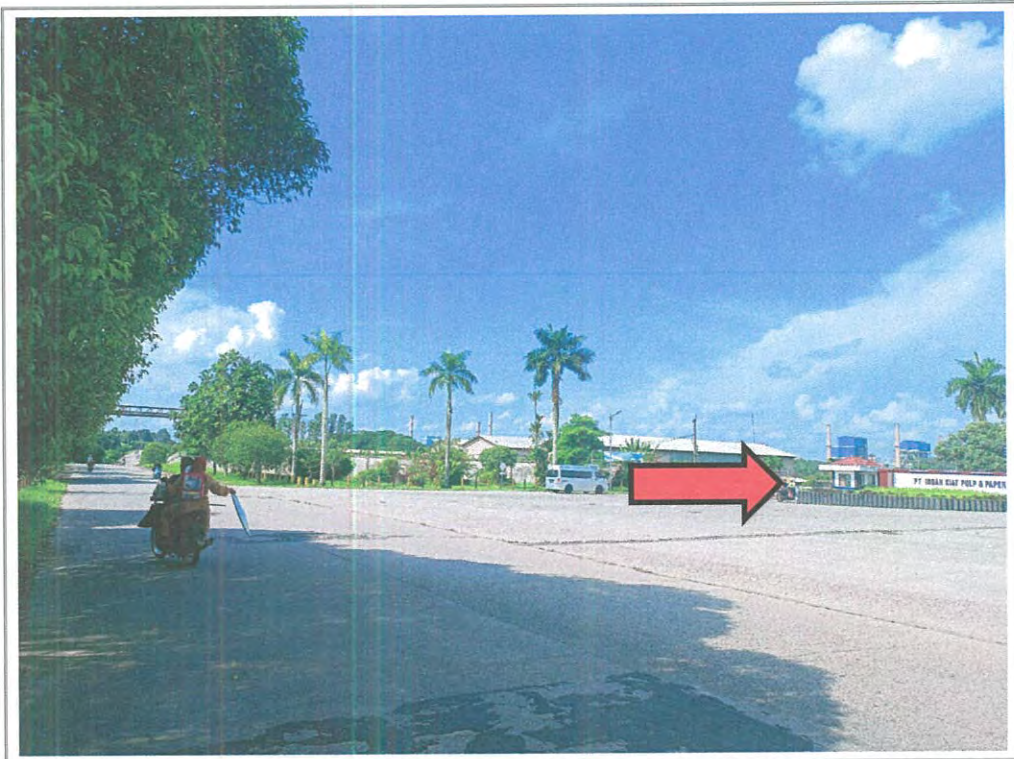
TAMPAK SITUASI JALAN KAWASAN INDUSTRI AKSES KE LOKASI PROPERTI DI SEBELAH KANAN
