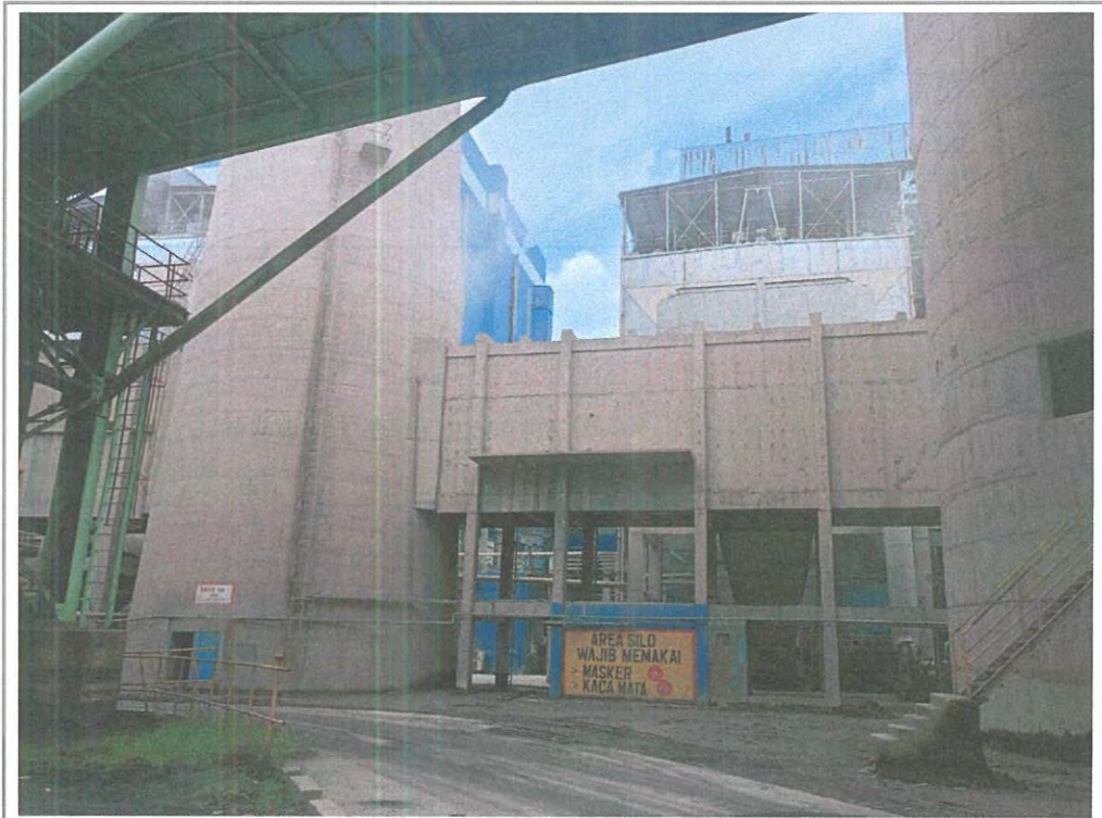
TAMPAK LOKASI SHGB NO. 89
