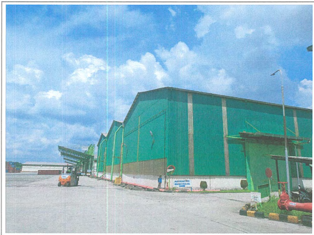
TAMPAK LOKASI SHGB NO. 474
