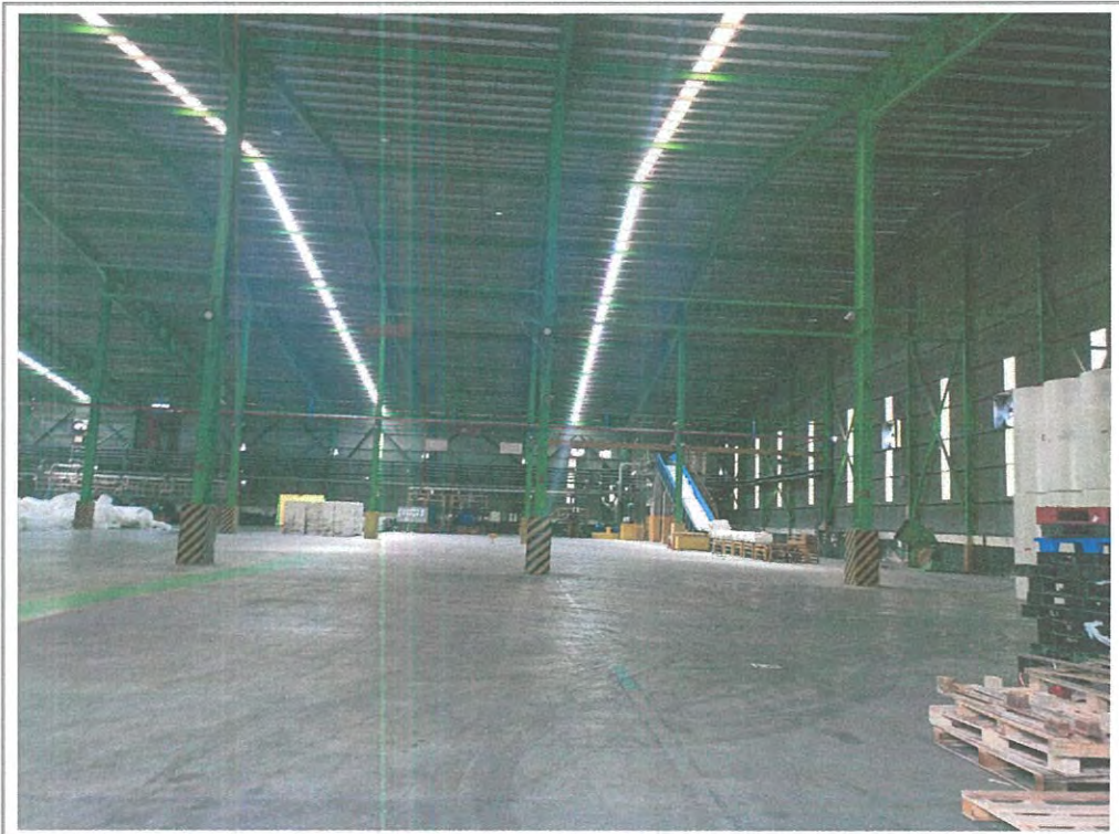
TAMPAK LOKASI SHGB NO. 91 (DALAM PABRIK)
