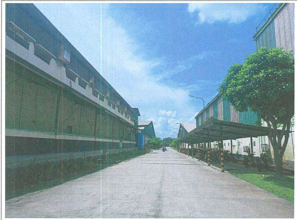
TAMPAK LOKASI SHGB NO. 91
