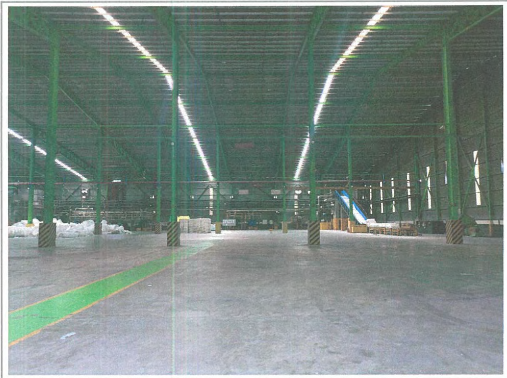
TAMPAK LOKASI SHGB NO. 91 (DALAM PABRIK)
