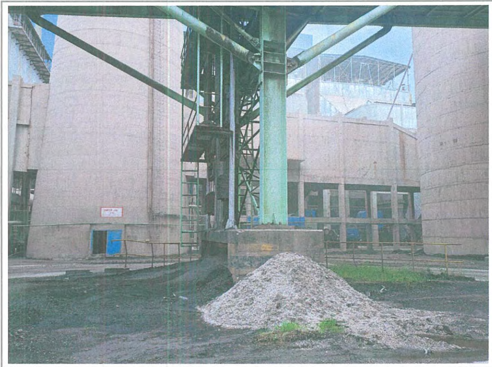
TAMPAK LOKASI SHGB NO. 89
