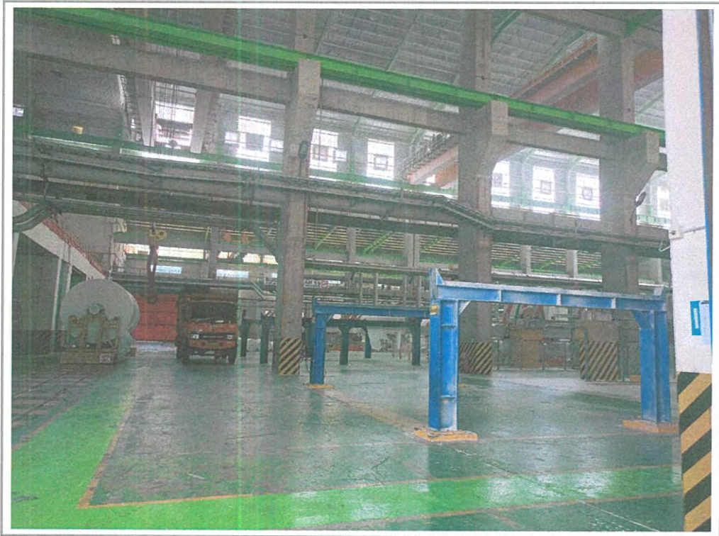
TAMPAK LOKASI SHGB NO. 473 (DALAM PABRIK)
