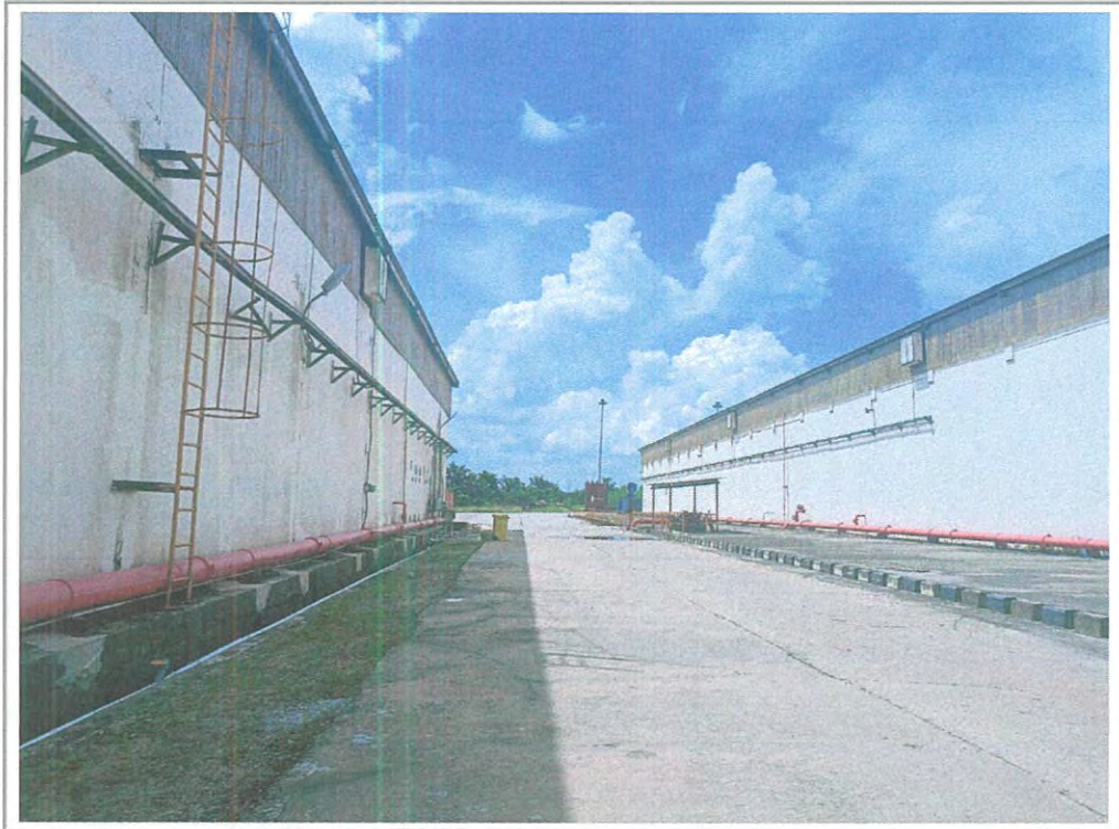
TAMPAK LOKASI SHGB NO. 473
