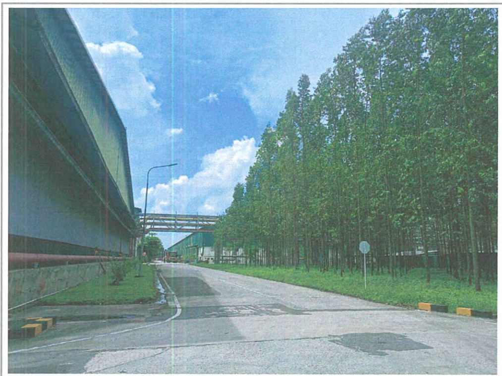
TAMPAK LOKASI SHGB NO. 475
