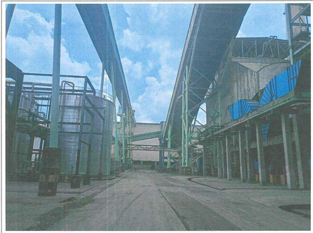
TAMPAK LOKASI SHGB NO. 89
