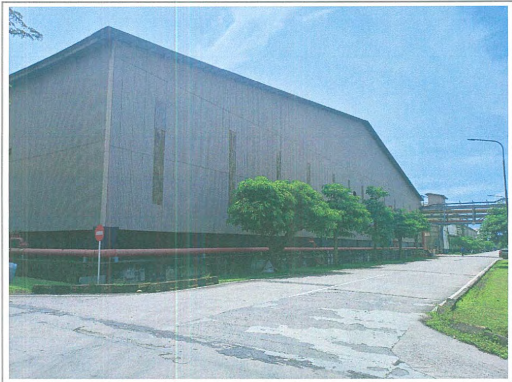
TAMPAK LOKASI SHGB NO. 91
